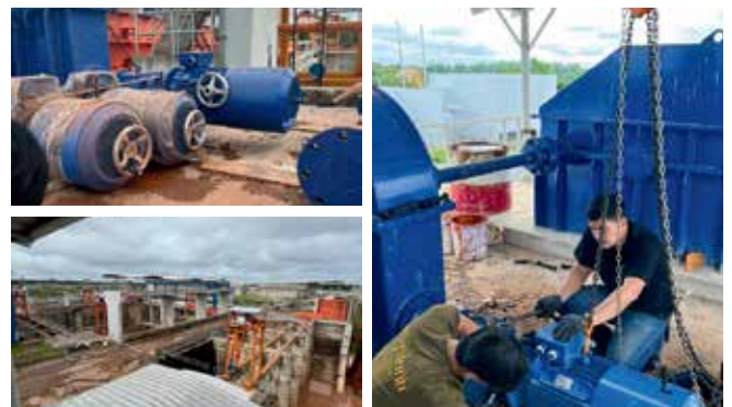
งานประตุน้ำจังหวัดหนองคาย
